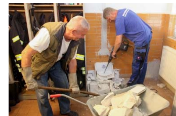
Ausbau: Erweiterung der Umkleide der Feuerwehrfrauen
