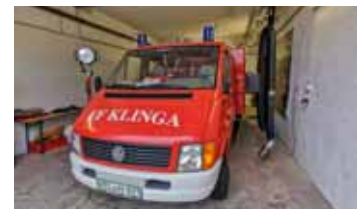
Gerätehaus: Abgasabsaugereinrichtung eingebaut
